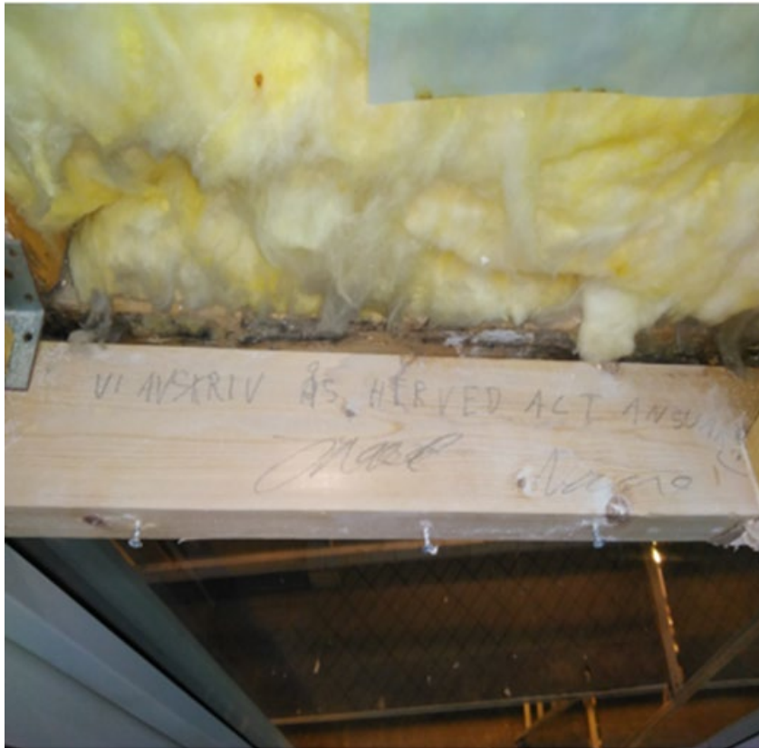
Figur 18. Figur 1. Bilde som viser bjelke i taket mellom byggetrinn én og to, over veggen som er mellom treningssenteret og badet
