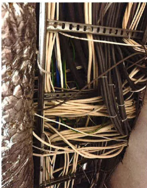
Figur 15. Bilde av overfylte kabelstiger
