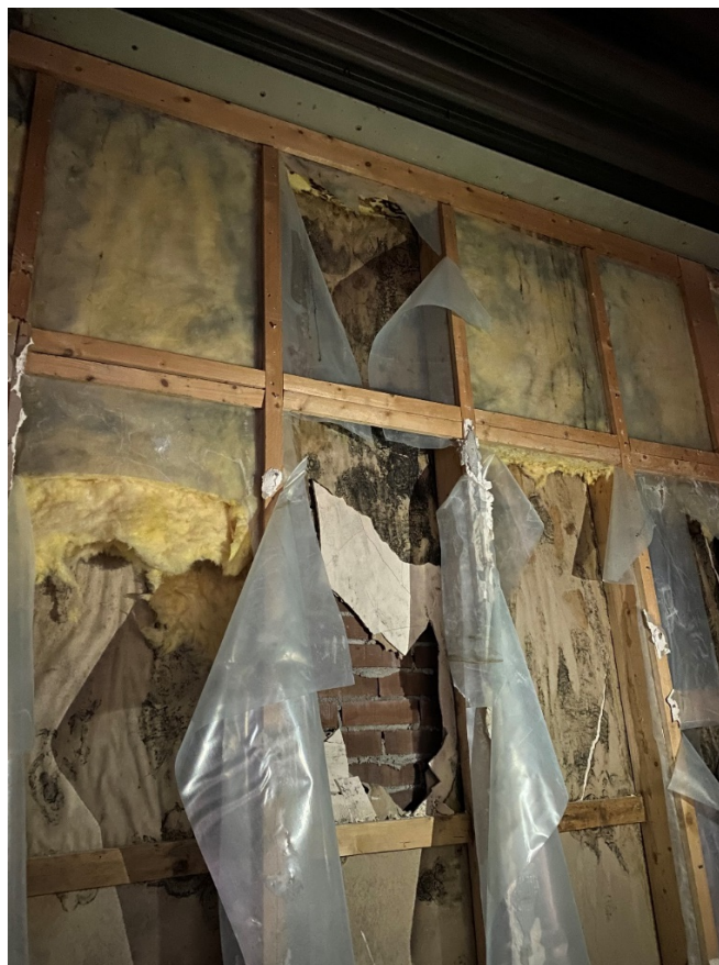
Figur 19. Bilde som viser fuktskader i teglsteinsvegg
