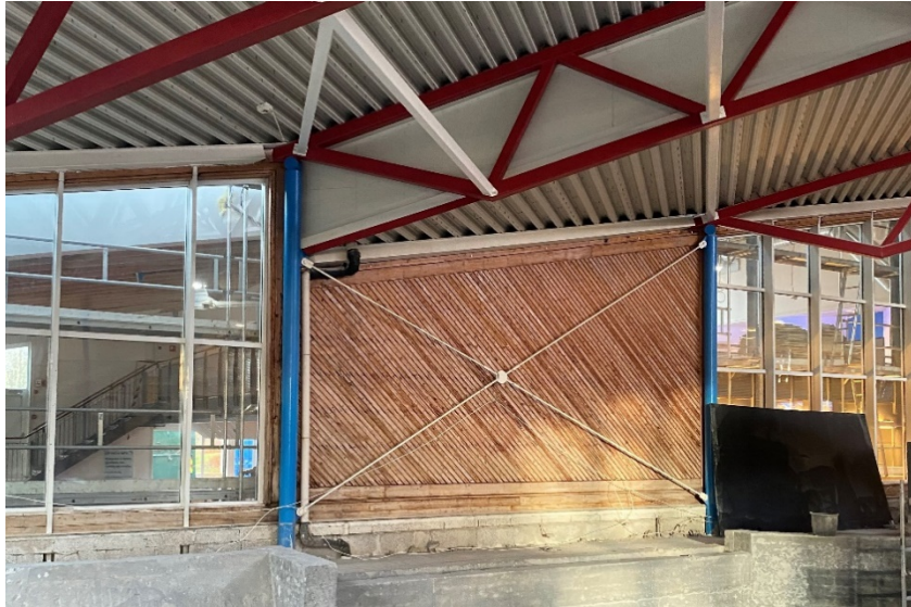
Figur 17. Bilde som viser vegg mellom basseng og gym
