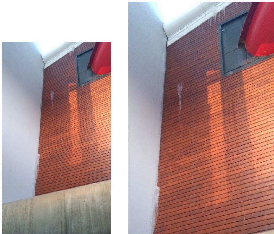
Figur 13. Bilde som viser isdannelser i sklietårnet
