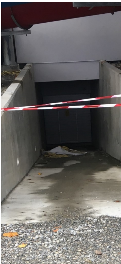
Figur 14. Bilde som viser at deler av taket har falt ned
