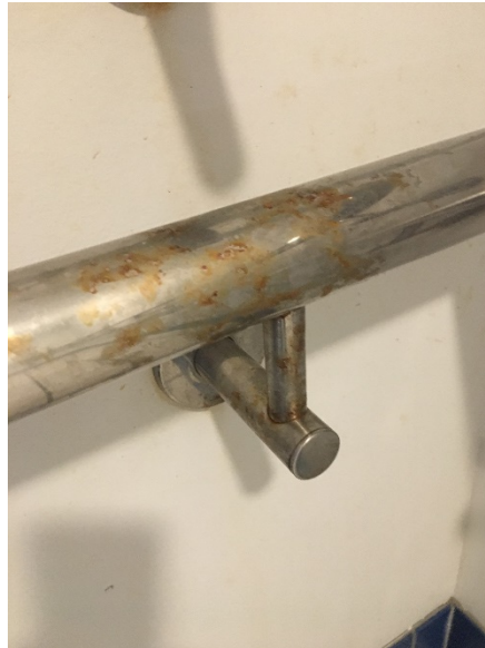
Figur 12. Bilde som viser rust på rekkverk
