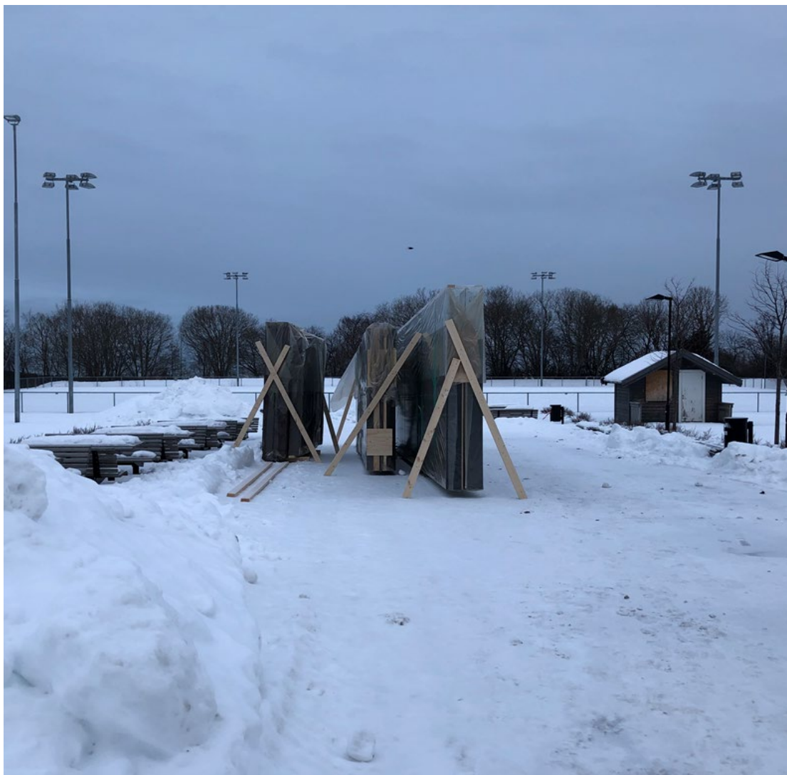
Figur 9. Bilde av usikrede element på byggeplassen
